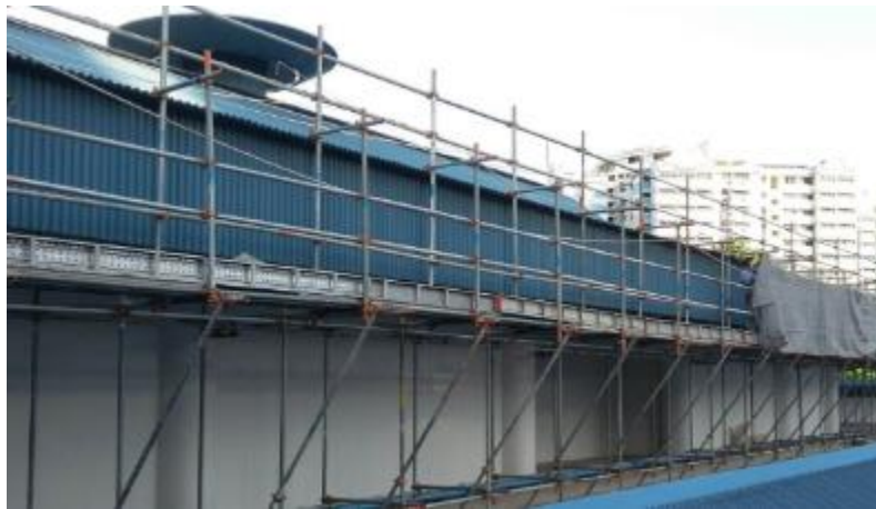
圖 32 懸挑式腳手架
