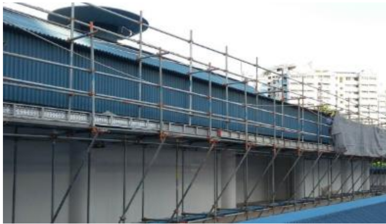
图32 悬臂式脚手架
