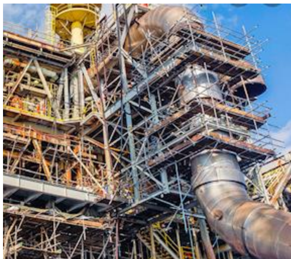
图33 扣件式管道脚手架
