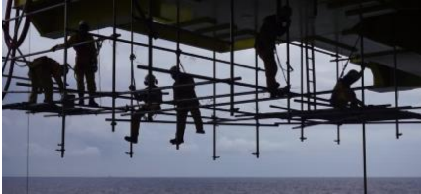
图31 悬挂式脚手架
