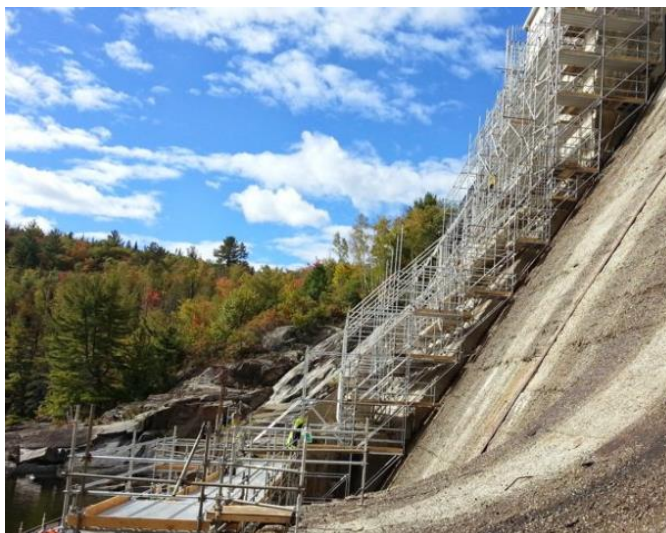
图34 系统脚手架
